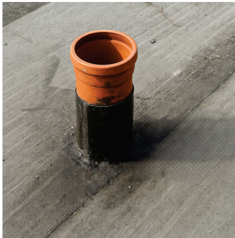
Abbildung 3 Hochzug bei durchgeführtem Rohr
